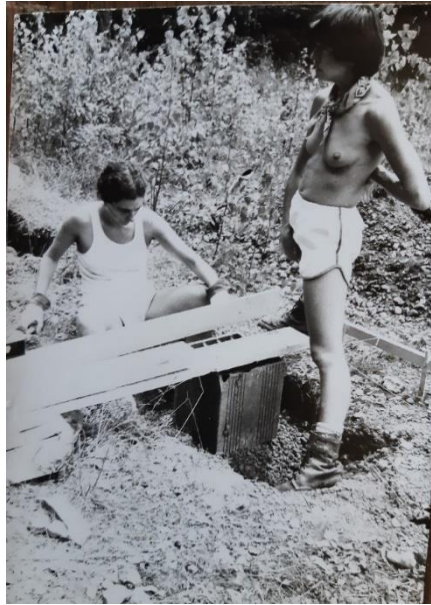
Fonds personnel, construction d'une maison à la Roche-sur-Yon par un groupe de femmes, 1977
